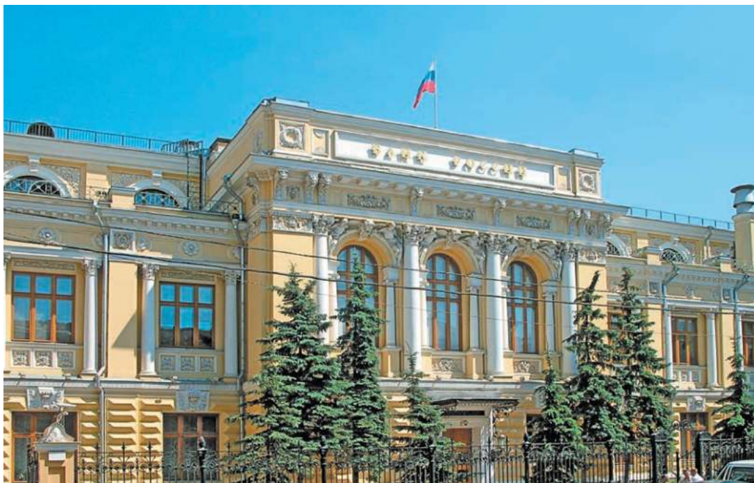
Рис. 2. Здание Центрального банка в Москве
